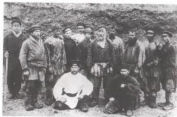
Строители Ташкентской ж. д. 1903 г.
