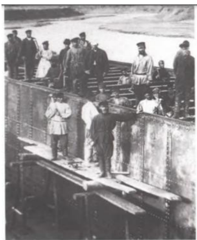
Строители Ташкентской ж. д. 1903 г.
