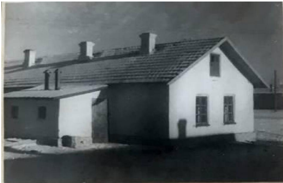
Сурет 2 – Сабаннан салынған 4 пәтерлі тұрғын үй (Урал қаласындағы К.Е. Ворошилов атындағы № 231 зауыт). (ҚР ПА. 708 қ. 8 т. 1734 і. 7 п.) [Figure 2 – A four-apartment residential building made of straw (Plant No. 231 named after K.E. Voroshilov, Oral city). (AP RK. F. 708. Inv. 8. C. 1734. P. 7)]
