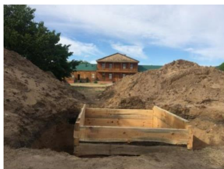
4-сурет. №1-құдықтың ішкі сұрыпының деңгейі [Fig. 4. The height of the inner frame of the well No 1]
