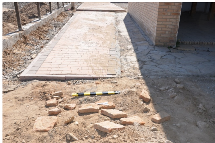
Рис. 2. Мавзолей Аль-Ходжа-ата. Скопление обломков средневековых кирпичей после землеройных работ. Фото 2021 г.
